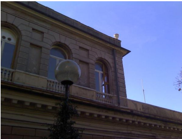
Figura 5: Muratura esterna Nord, piano terzo
